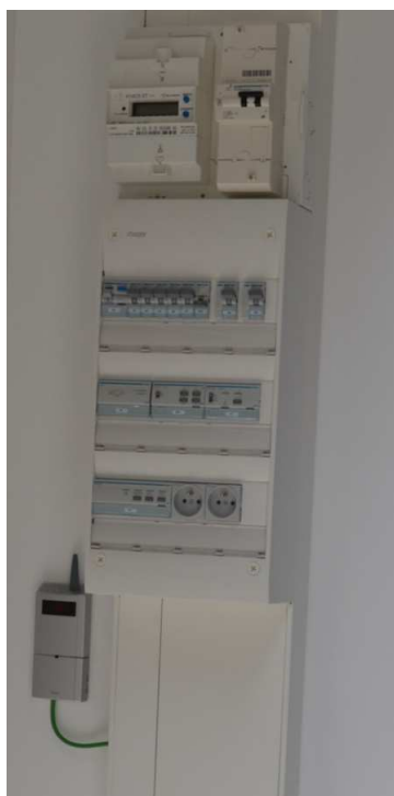
Cellule intérieure "Bureau" : mise en œuvre du bus KNX appliqué à l'éclairage et au chauffage.
